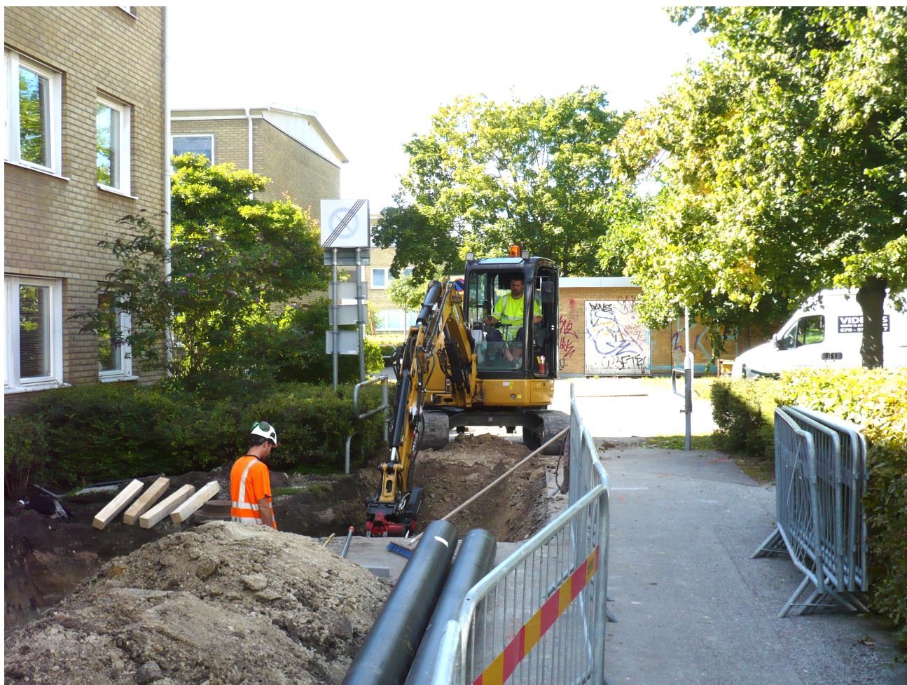
Kulvertbygget i full gång
