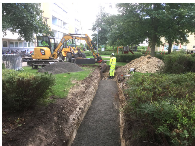
Grävning för nya värmekulvertar
