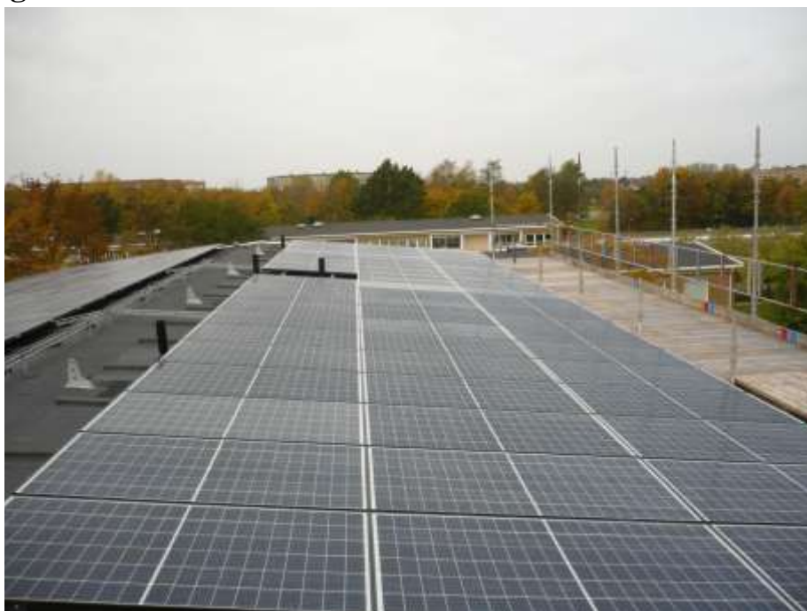
Solcellerna på Tulpangatan 8
