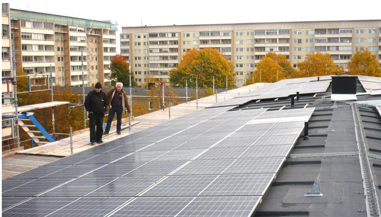
Styrelsens byggnadsansvarige Bo Raneheim och fastighetsskötare Andrzej Fulmyk inspekterar solcellerna på taket Tulpangatan 8 Foto Ragnar Danielsson
