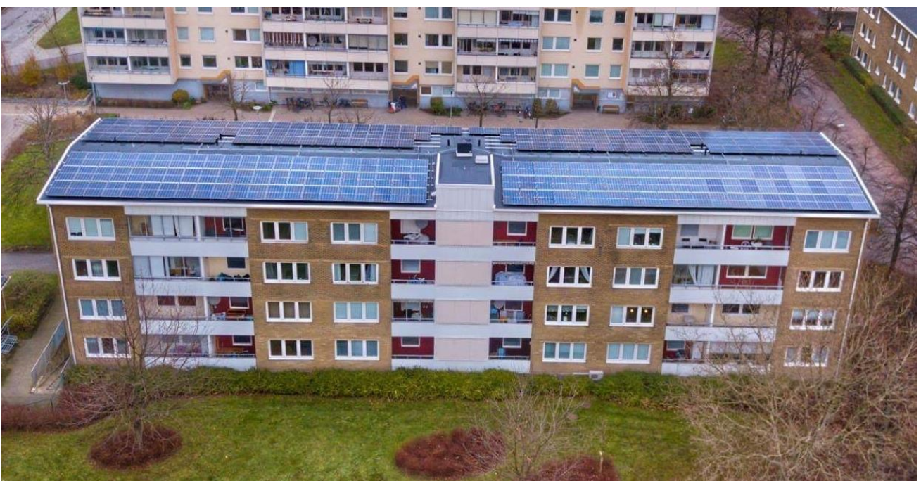
Bild: Solceller Tulpangatan 8
