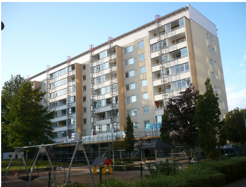
Underhållsarbetena med balkongerna fortskrider
